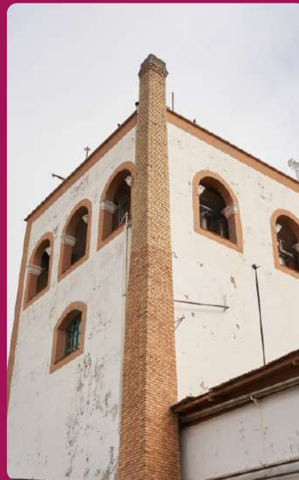
PEINADO TWIN CHIMNEYS
