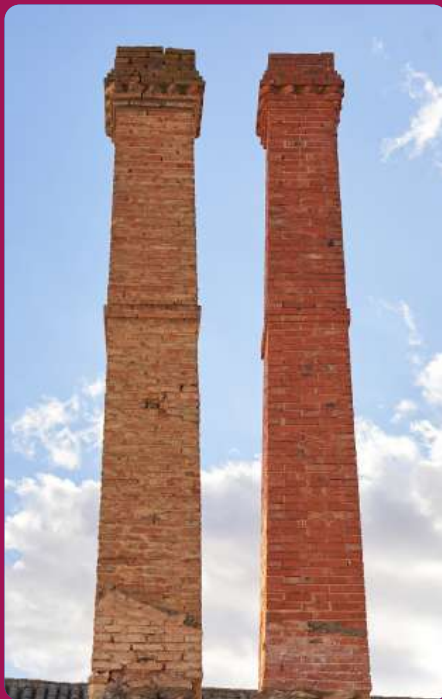
TWIN PEINADO CHIMNEYS
